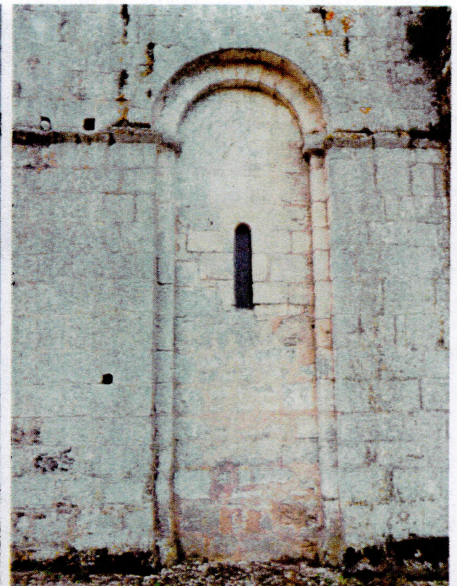
Élévations du chevet et du clocher : enduits et joints dégradés, trous de boulins à reboucher, lichen et mousse en pied de mur liés aux eaux de pluie
