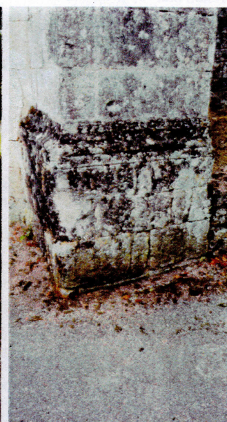
Contrefort angle Sud, vue Sud, détail de la modénature
