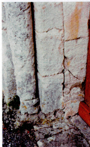
Partie basse du portail Nord, pierres de la colonne et du jambage Nord dégradées et fissurées, colonne Sud refaite en 2012
