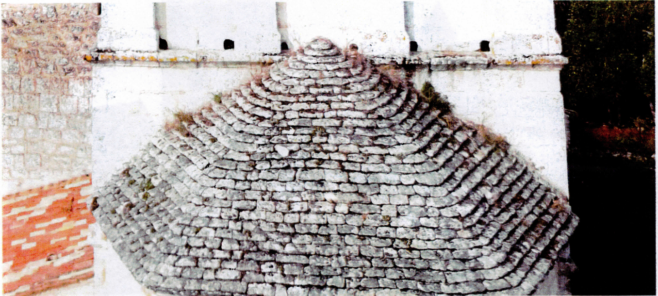
Vue générale de la couverture en lauze du chevet sur forme de pose en béton de ciment (0, 10), végétation au niveau des solins
