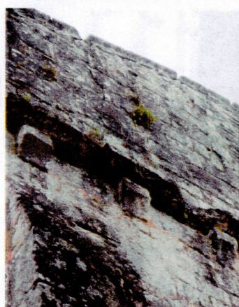
Pignon : pierres épauffrées, végétation dans les joints et sur la corniche
