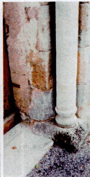
Partie basse du portail Nord, pierres de la colonne et du jambage Nord dégradées et fissurées, colonne Sud refaite en 2012
