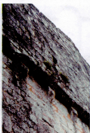
Pignon : pierres épauffrées, végétation dans les joints et sur la corniche
