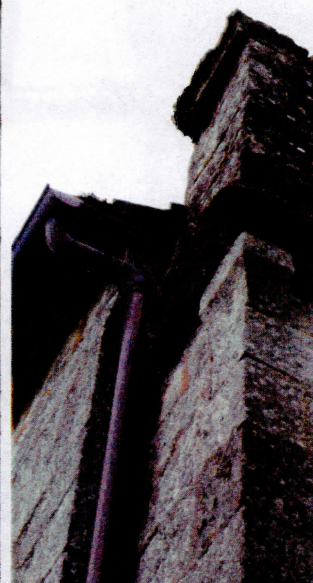
Angle Nord : pierres épauffrées, joints manquants et végétation
