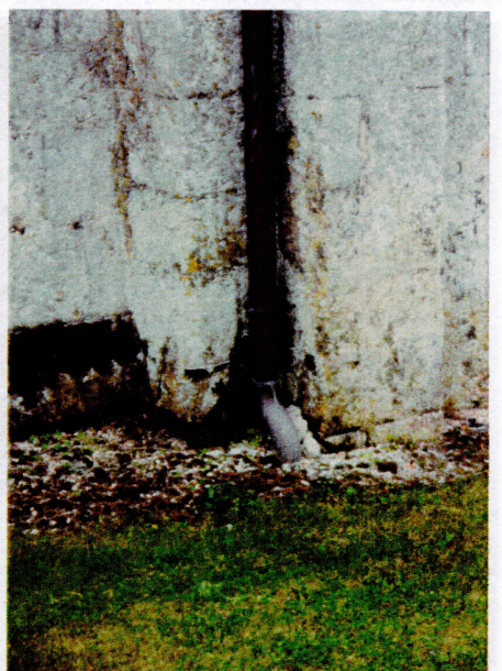
Descente d'eaux pluviales à l'angle entre le clocher et la nef : maçonnerie désorganisée avec pierre manquante, joints dégarnis et végétation abondante liées aux infiltrations en tête de maçonnerie, protection à revoir
