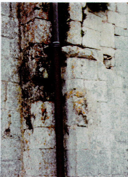
Descente d'eaux pluviales à l'angle entre le clocher et la nef : maçonnerie désorganisée avec pierre manquante, joints dégarnis et végétation abondante liées aux infiltrations en tête de maçonnerie, protection à revoir
