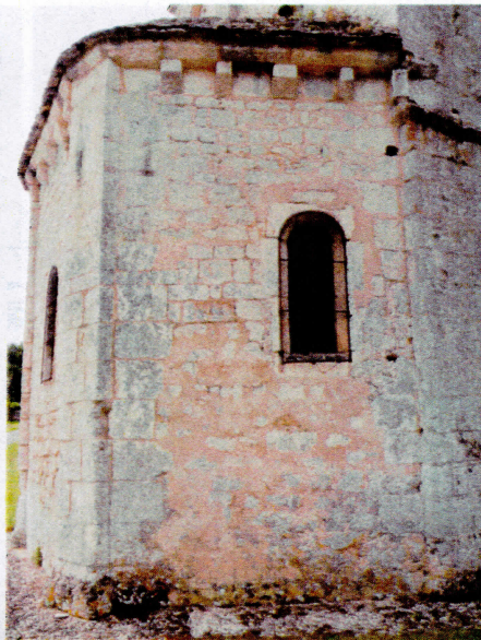
Élévations du chevet et du clocher : enduits et joints dégradés, trous de boulins à reboucher, lichen et mousse en pied de mur liés aux eaux de pluie
