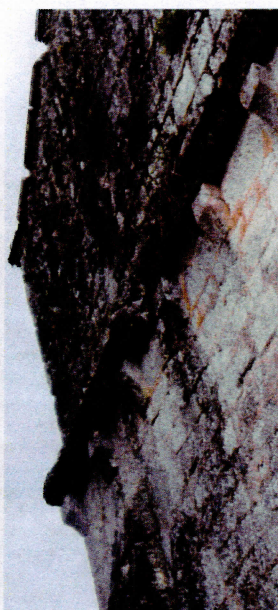
Angle Nord : pierres épauffrées, joints manquants et végétation
