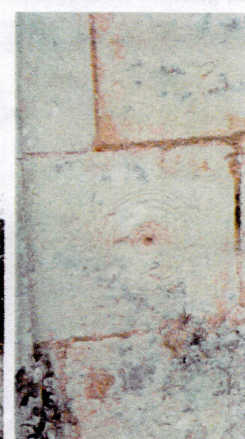
Graffiti à droite du portail Sud
