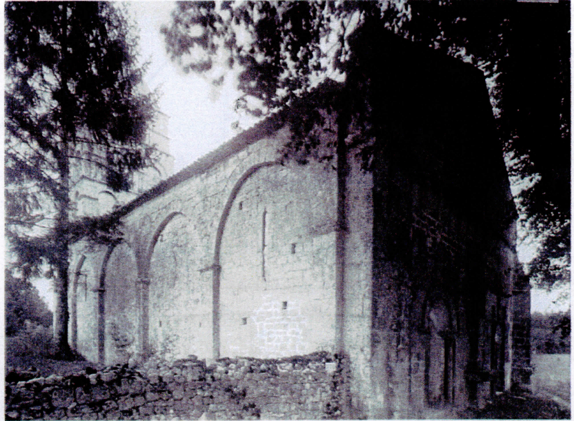
1919, Ensemble Nord-Ouest, Henri Heuzé, MH0027142
